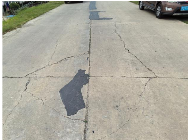
(2) 东村桥-阜漂高速段，长约 355m，现状路面为水泥砼路面，板块长约 4.5m，宽约 6m，道路整体情况较好，局部位置存在裂缝、坑槽等病害。
