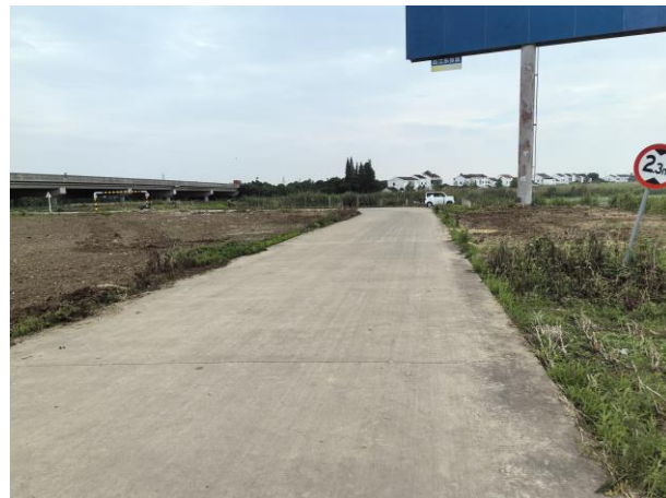
(2) 东村桥-阜漂高速段，长约 355m，现状路面为水泥砼路面，板块长约 4.5m，宽约 6m，道路整体情况较好，局部位置存在裂缝、坑槽等病害。
